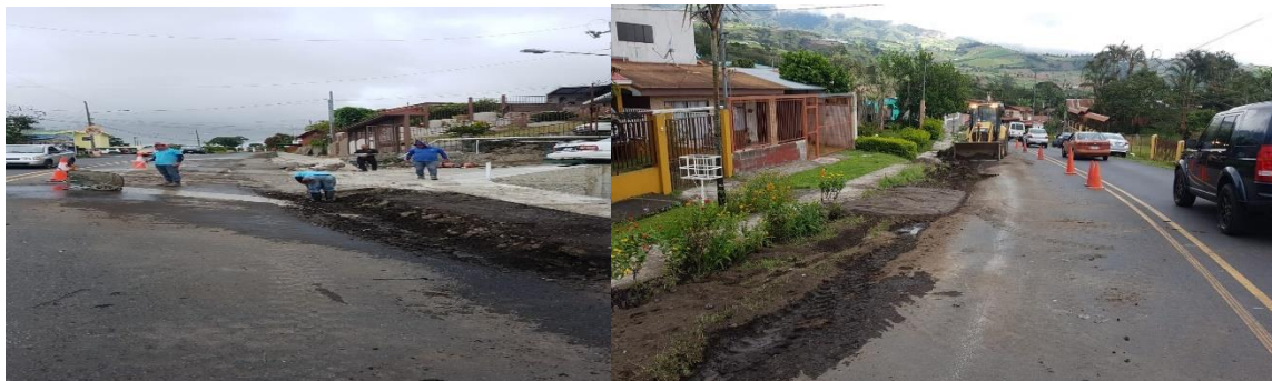
Fotos N°1 y N°2 Cambio de tuberías sector San Pancracio
