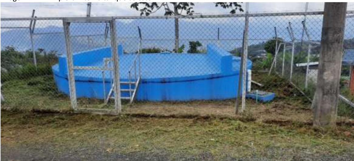
113 114 Imagen N°12: Tareas de limpieza (chapia) en tanque Arturo Quiros
