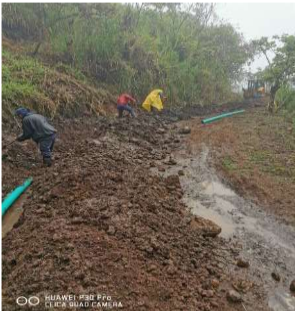
Imagen N°2 y 3: Sustitución de tubería Camino Toro Loco.
