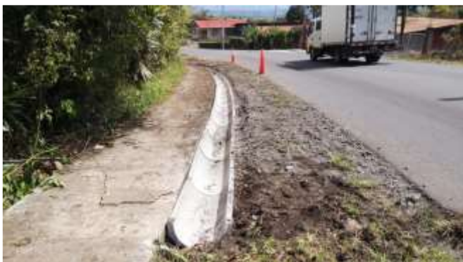
204 Imagen N°22 Alcantarillado San Pancraccio ruta 10 205
