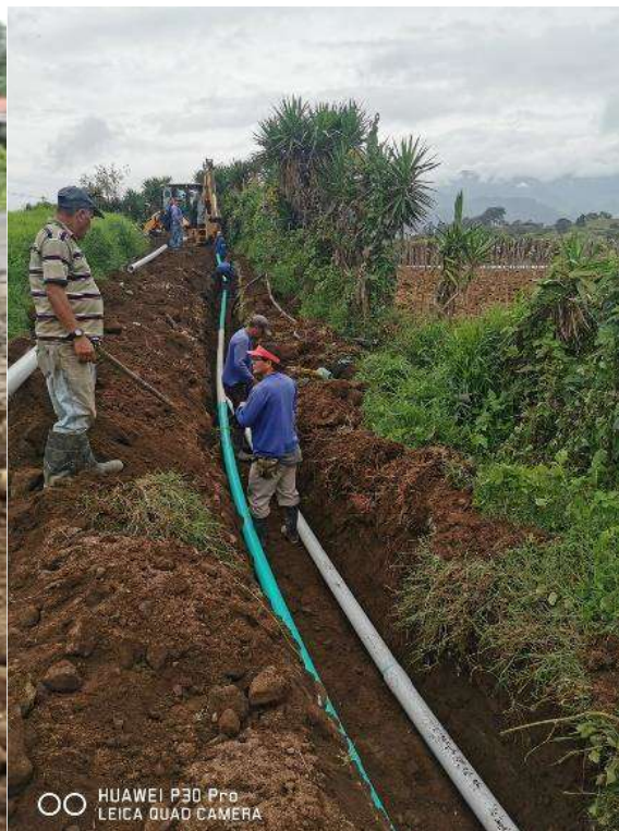
Imagen N°4 y N°5: Sustitución de tubería en Las Aguas y La Hacienda.
