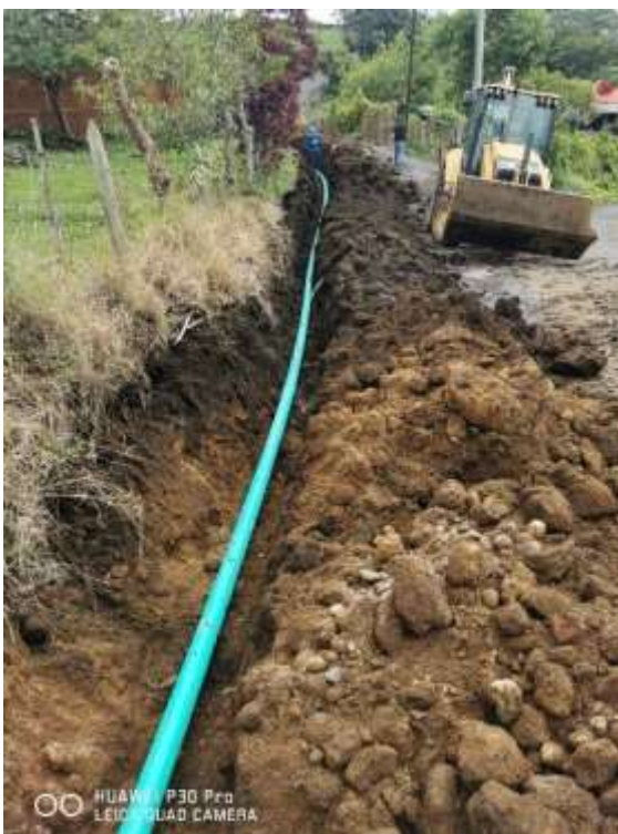
Imagen N°4 y N°5: Sustitución de tubería en Las Aguas y La Hacienda.
