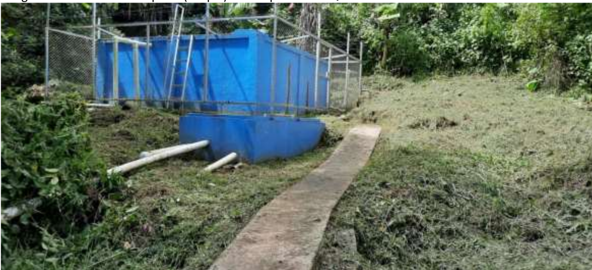
115 116 Imagen N°13 Tanque Matías Solano, trabajos de chapia
