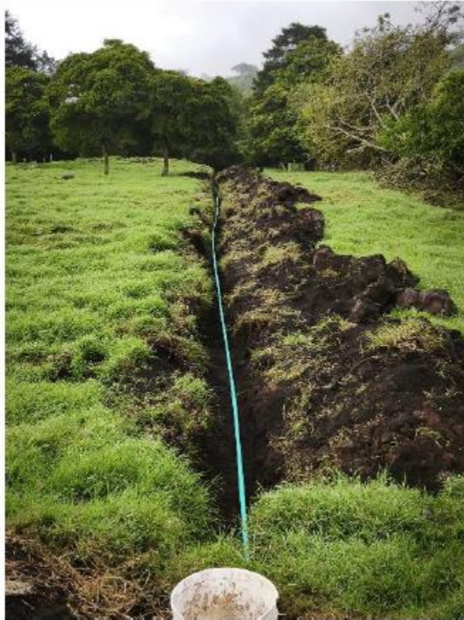
Imagen N°2: sustitución de tubería-San Isidro
