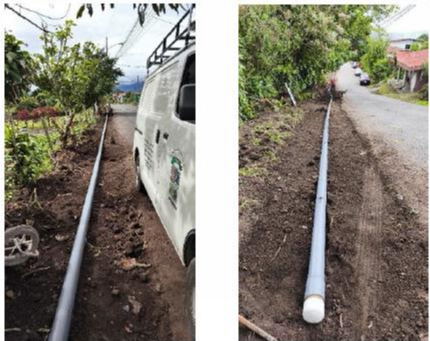
Imagen N°3. sustitución de tubería-La Trinidad
