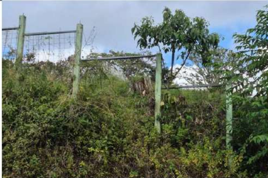
Imagen N°7: malla perimetral existente.
